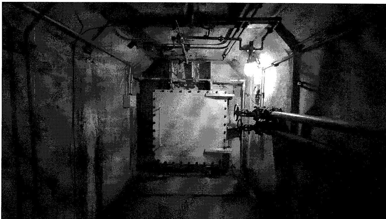
Cota 43, ingreso a cámara espiral y tubo. No se observan filtraciones, etc.
