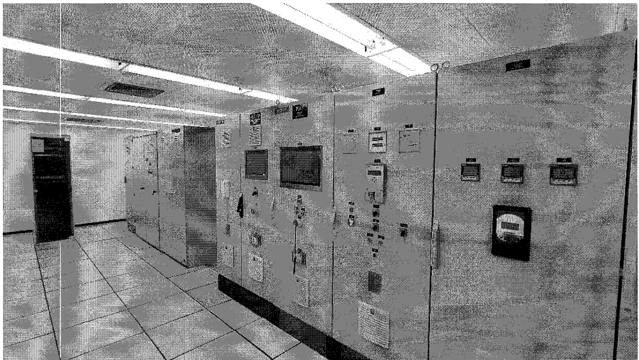
Salas de control locales, que se vienen modernizando. Cuentan con detección de humo a nivel del techo y debajo de piso técnico
