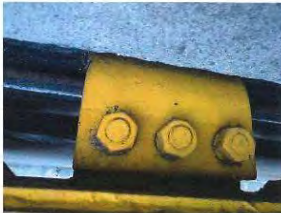
xiii. Zapata de puesta a tierra
