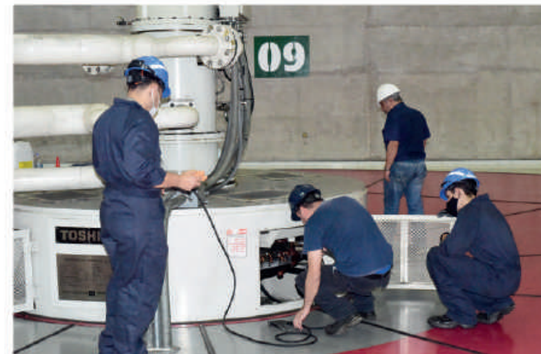
Trabajo de mantenimiento de generadores.
