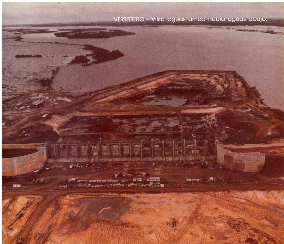
Figura 2 Fotografía tomada durante la excavación del vertedero Aña Cua
